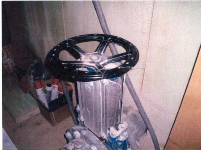
**Bild 4:** Sämtliche Schieber und Kugelhähne wurden gegen Manipulation mit Plombierdraht und markierten Plomben versehen.
