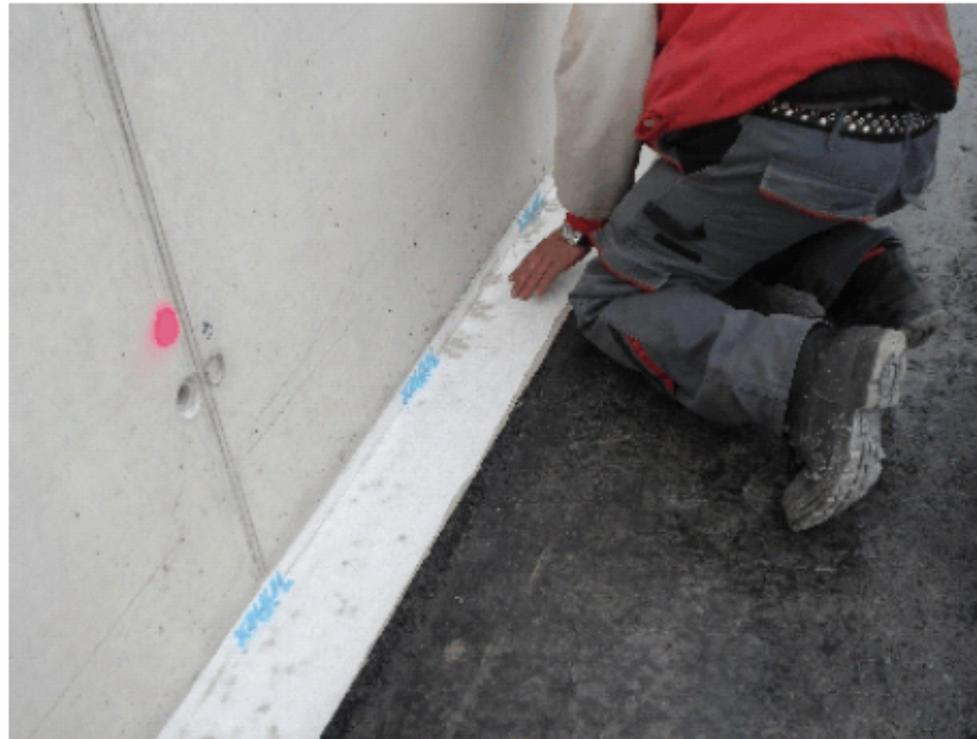
Bild 1 Einlegen der Vliesarmierung auf eine erste Lage Flüssigkunststoff-Folie im Übergang Fläche - Wand
