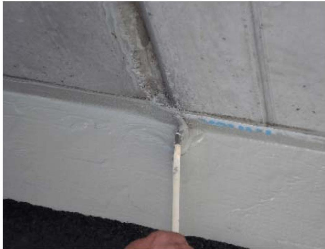
Bild 2 Auftrag der zweiten Lage Flüssigkunststoff-Folie auf die Vliesarmierung auf der Asphalttragschicht und an der Silo-Wandplatte
