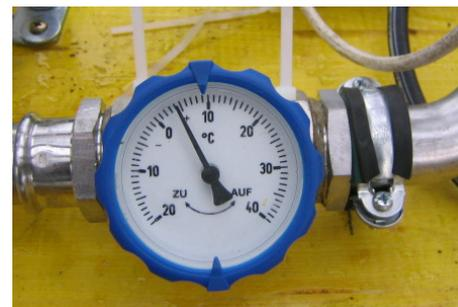
Thermometer für Erdwärmesondentemperatur
