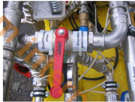
6. Erdwärmesonden und eventuell angeschlossene Zuleitung füllen und entlüften.
