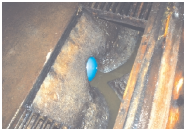
Abb. 1: Absperrballon im Schwemmkanal
