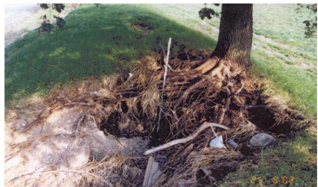
**Bild 15:** Böschungserosion landseitig infolge von Baumbewuchs und Überströmung
