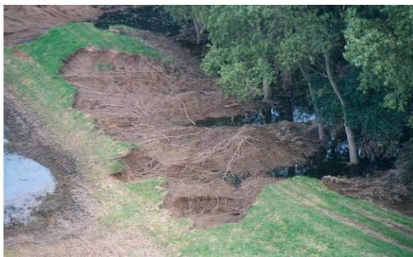
**Bild 14:** Bei Hochwasser freigelegte Durchwurzelung eines Deiches infolge von Baumbewuchs
